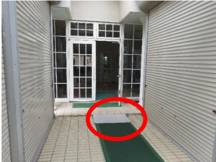
【福利棟入口(スロープ)】
