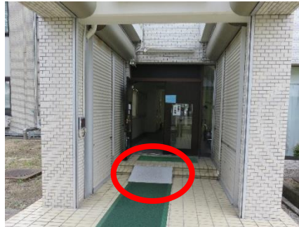
【管理棟入口(スロープ)】
