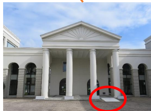
【正面入口(スロープ)】
